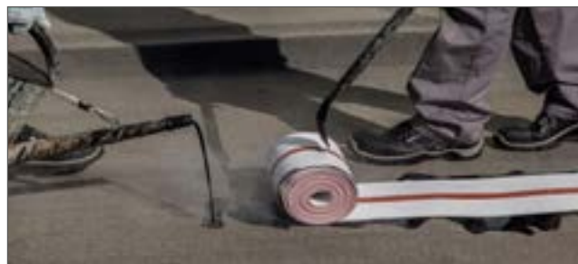
RedLINE auf 1. Lage bituminöser Dichtungsbahn aufgegossen
